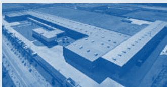
Hörmann Tianjin, Kína
